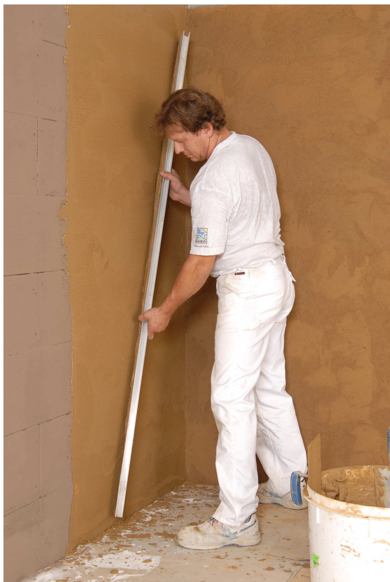
Zarovnání hliněné jádrové omítky pomocí latě
