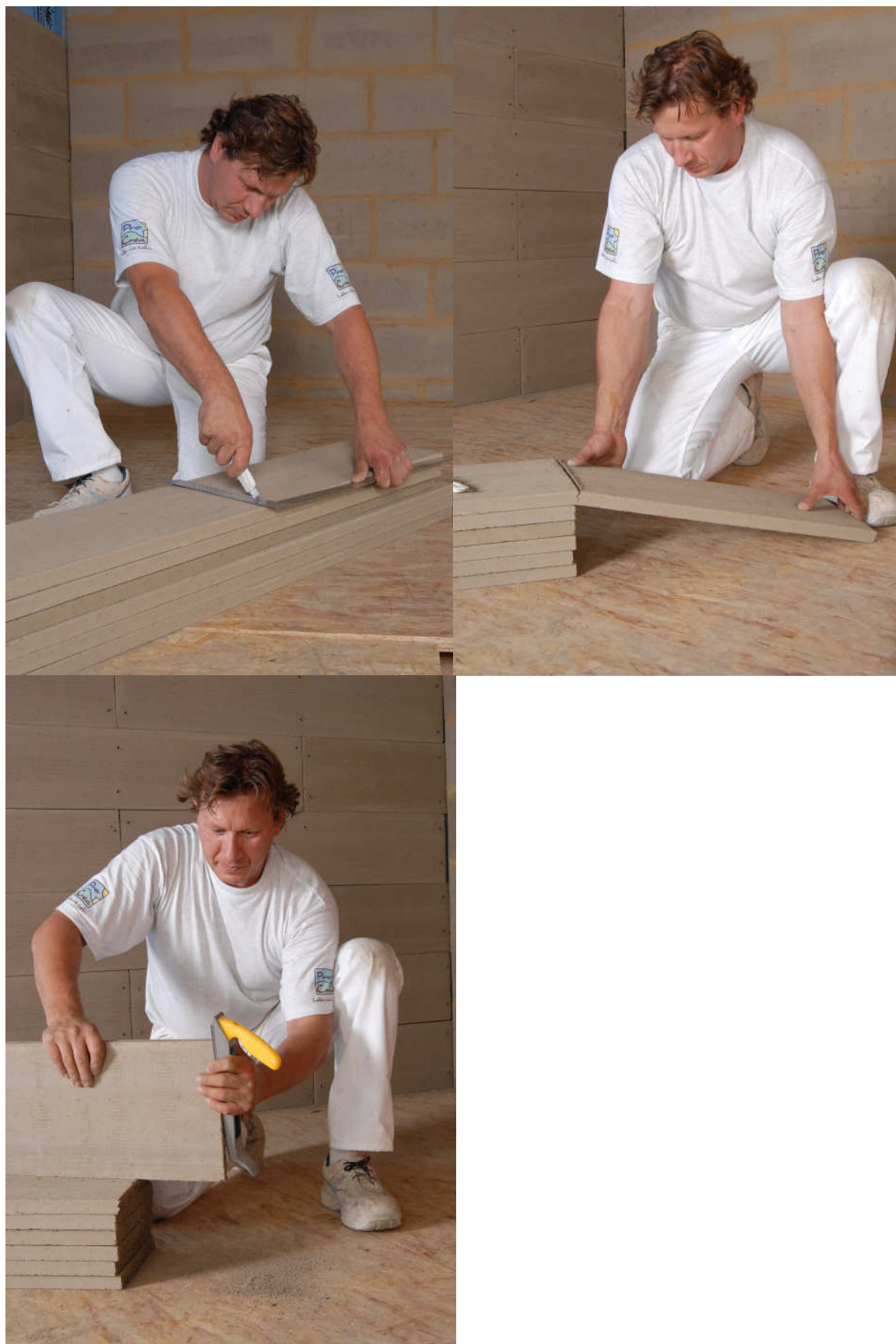
Ukázky řezání hliněných panelů odlamovacím nožem
