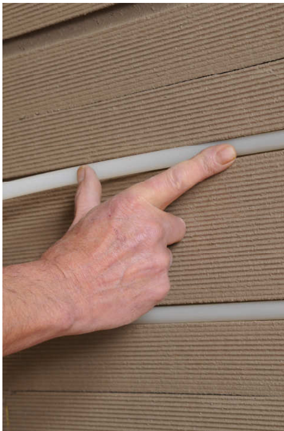
Modelová stěna hliněných panelů se stěnovým topením a hliněnou omítkou
