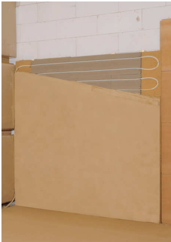
Modelová stěna hliněných panelů se stěnovým topením a hliněnou omítkou
