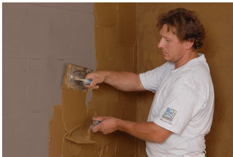
Zarovnání hliněné jádrové omítky pomocí latě
