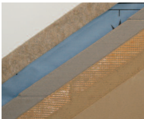
Konstrukční příklad pro stěnu z hliněných panelů
