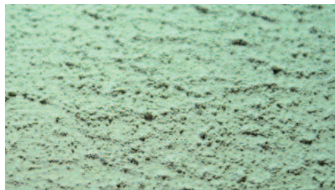
Hrubě strukturovaného povrchu nátěrové omítky docílíte pomocí speciálního válečku.
