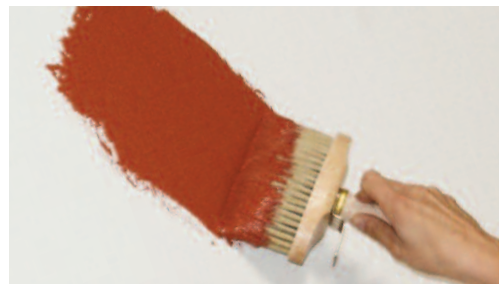
Rychle a rovnoměrně rozetřete pomocí štětky.
