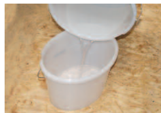
Do kbelíku nalijte zhruba \frac{3}{4} potřebného množství vody
