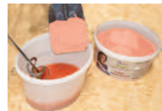
Přidávejte postupně suchou omítku a promíchejte měchačkou
